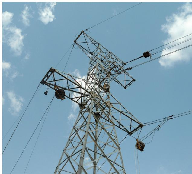
Após os trabalhos de montagem e revisão de torres e estruturas, entra em ação o processo de lançamento de cabos. Essa etapa abrange diversas outras atividades, como a construção da proteção ao longo da linha, içamento de cadeias, lançamento dos cabos pilotos, cabos para-raios e condutores, regulagem dos cabos, grampeação e ancoragem. A produção média para essa atividade em linhas de transmissão de 500kV é de 30km, ao mês.
